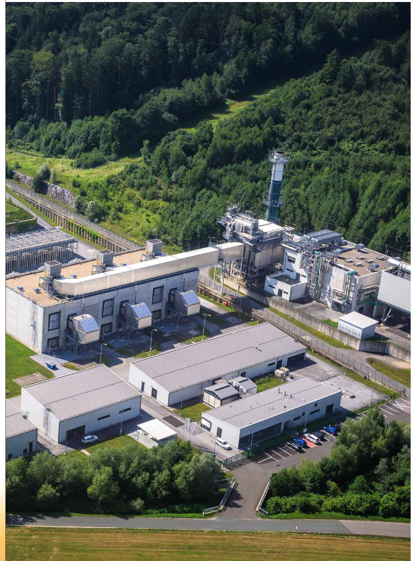
Kompressorstation und Abwärmenutzungsanlage in Weitendorf.
